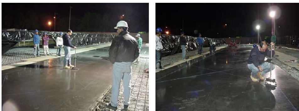
Fig. 12 Medición de planicidad con Dipstick
