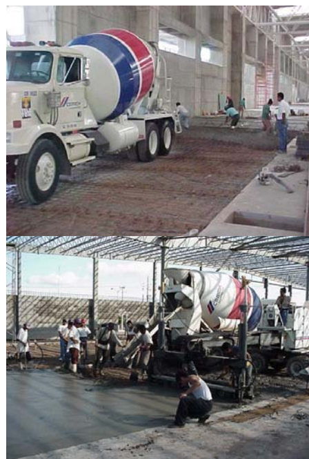
Fig. 1 Colocación de Concreto para Pisos
