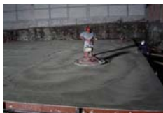
Figura 3. Piso con Concreto de Contracción Compensada tableros de 25x22 metros.
