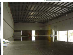
Figura 4. Piso con Concreto de Contracción Compensada tableros de 30x31 metros.
