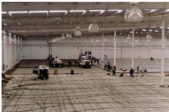
Fig. 8 Tendido de Cables para sistemas de piso Postensado
